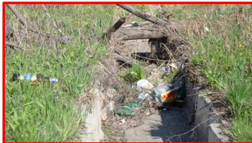
**Не очищенная от мусора система водоотвода (водоотводные, прикромочные лотки, быстротки, нагорные канавы и т.д.)**
